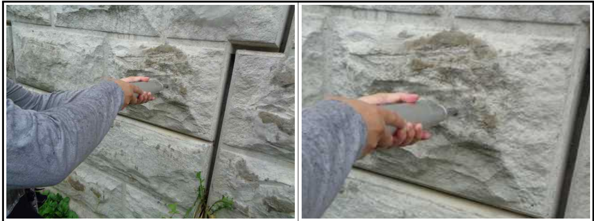
【그림 8.3.6】 슈미트해머를 이용한 반발경도시험 전경
